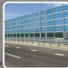
Дорожное строительство, крепление шумозащитных экранов
